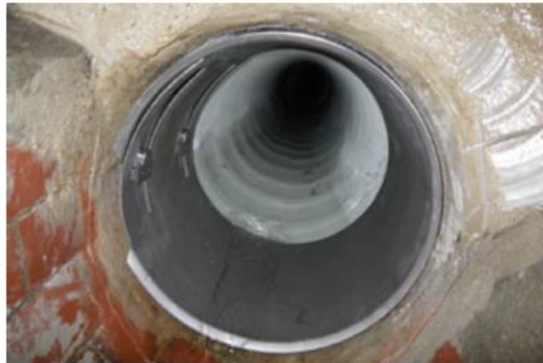
Bild 5: QUICK-LOCK-Linerendmanschette vom Schacht aus
