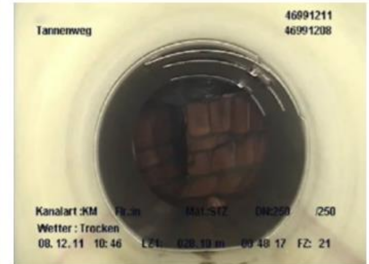
Bild 6: QUICK-LOCK-Linerendmanschette vom Kanal aus
