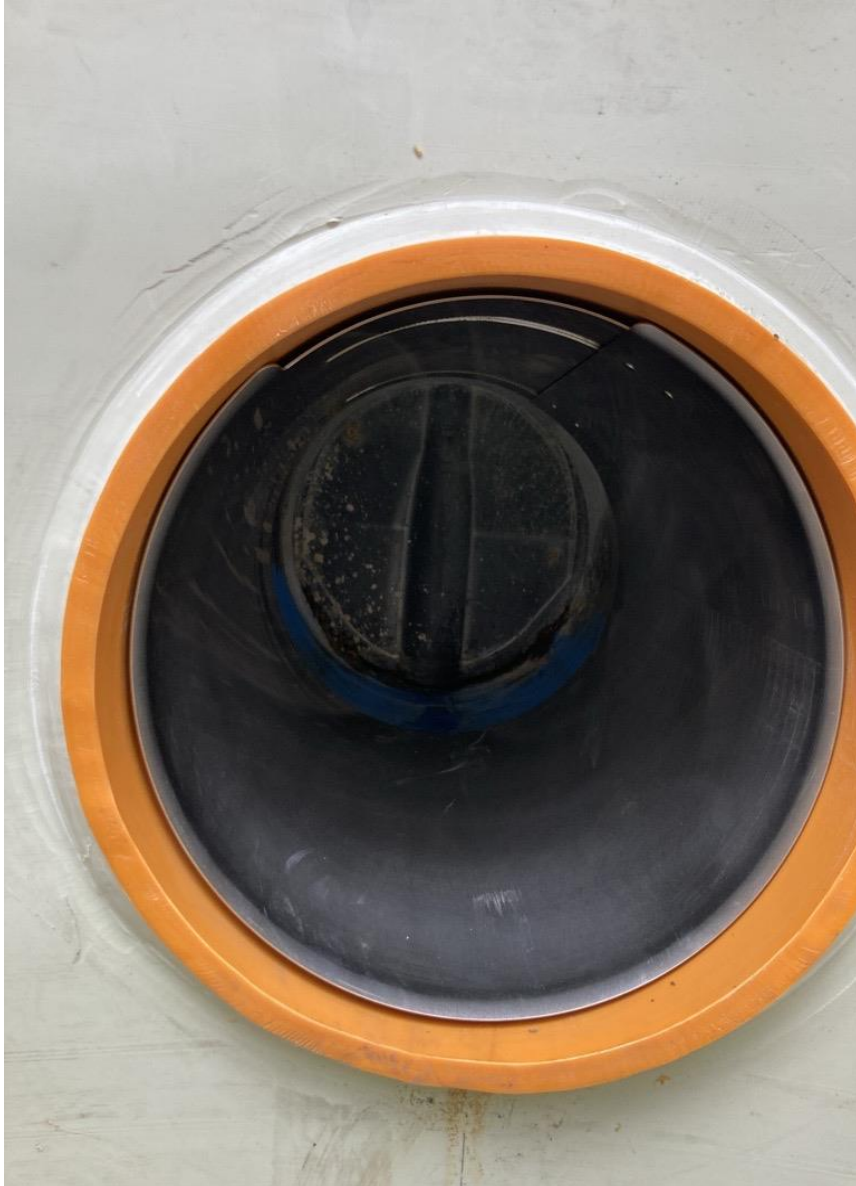
Bild 5: QUICK-LOCK-Linerendmanschette vom Schacht aus
